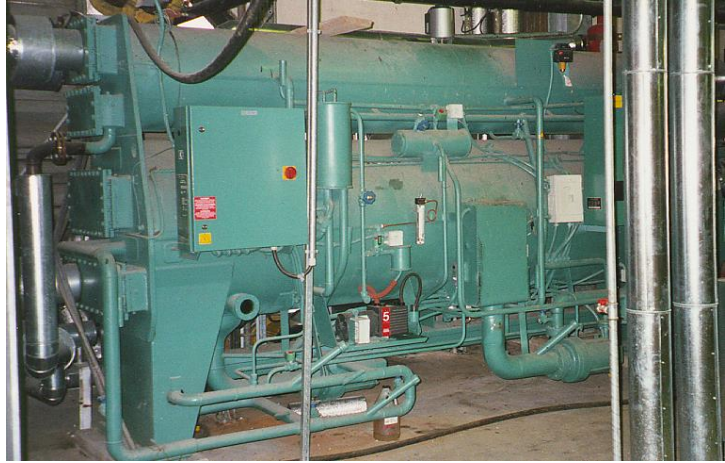
Absorptionskälteanlage
